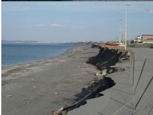
Figura 1 - Erosione con evidenti danni su strutture, lungo la costa di Furnari (Messina.)
